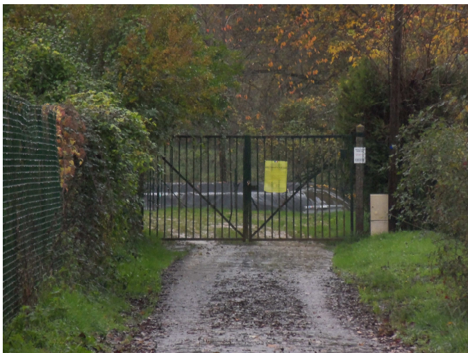
Affichage sur le site du captage
